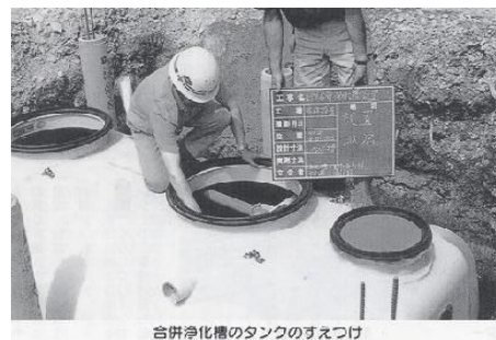
合併浄化槽のタンクのすえつけ
