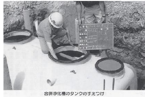
合併浄化槽のタンクのすえつけ
