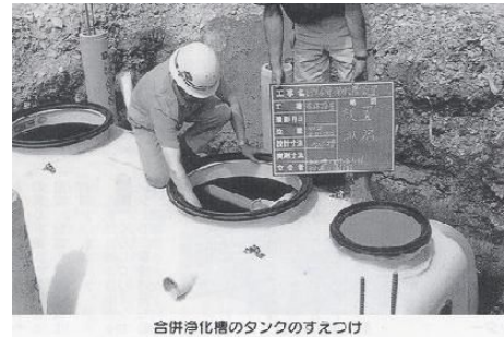
合併浄化槽のタンクのすえつけ
